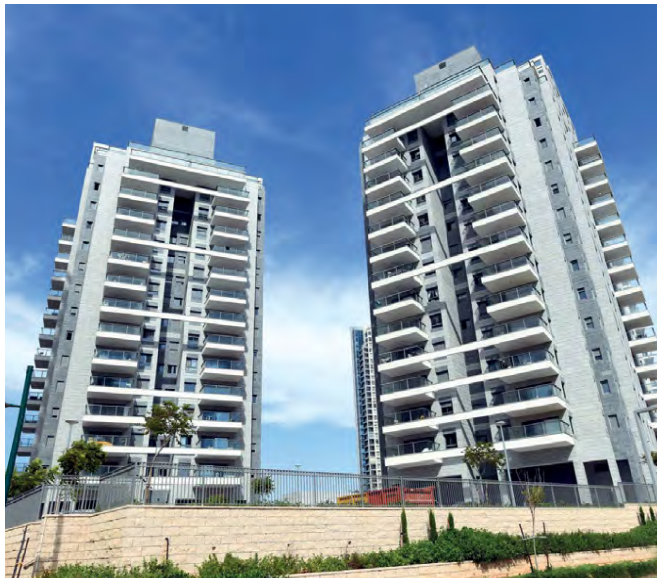
יזם: גינדי החזקות | תכנון אדריכלי: קיקה ברא"ז אדריכלים | תכנון קונסטרוקטיבי: ישראל דוד | שנים: 2017-2019 | היקף פיננסי: 115 מיליון ש"ח
